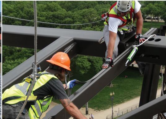
Les installateurs, portant leurs équipements de prévention des chutes, installent des pieds de Bird-Shock sur les nouvelles importantes structures de DC.
